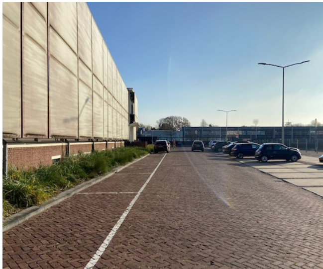
In de huidige situatie is er nog veel ruimte voor parkeren en weinig ruimte voor groen
